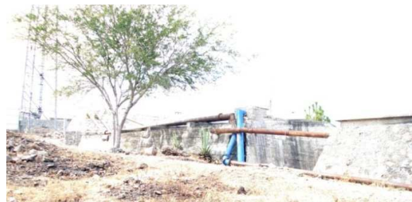
Imagen I.44. Tanque del Kinder. Fuente: H. Ayuntamiento 2012-2015.
