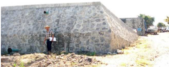
Imagen I.45. Tanque Colinas del Tepeyac. Fuente: H. Ayuntamiento 2012-2015.
