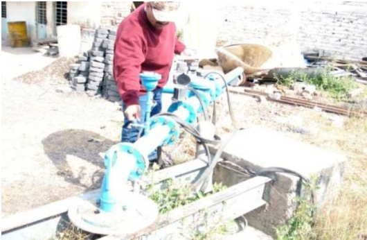
Imagen I.36. Pozo Federico Higareda. Fuente: H. Ayuntamiento 2012-2015.
