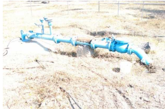
Imagen I.41. Pozo La Cañada. Fuente: H. Ayuntamiento 2012-2015.
